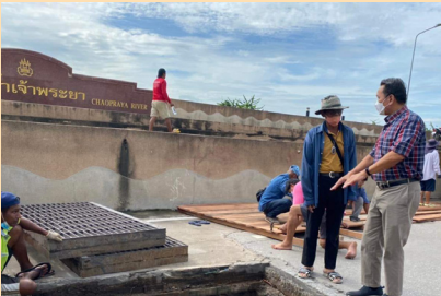
เจ้าหน้าที่ให้การบล็อกท่อระบายน้ำบริเวณหน้าเงินทุนหลักทรัพย์ เนื่องจากระดับน้ำแม่น้ำเพิ่มสูงขึ้น เพื่อป้องกันน้ำแม่น้ำไหลย้อนเข้ามา และใช้เครื่องสูบน้ำไฟฟ้าใต้ดินสูบน้ำออกไป
