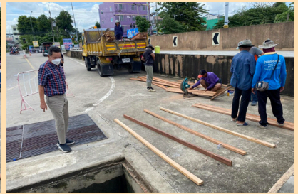
เจ้าหน้าที่เร่งทำการบล็อกท่อระบายน้ำบริเวณถนนริมแม่น้ำแยกกรุงไทย-ไประษณีย์ และบริเวณสะพานป้อมหนึ่ง เพื่อป้องกันน้ำแม่น้ำไหลย้อนเข้ามา
