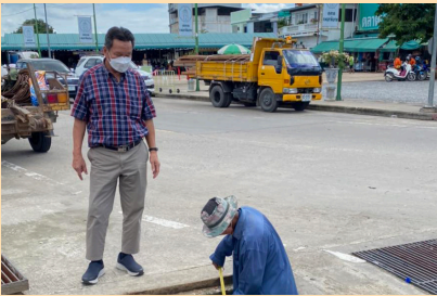
เจ้าหน้าที่เร่งทำการบล็อกท่อระบายน้ำบริเวณถนนริมแม่น้ำแยกกรุงไทย-ไประษณีย์ และบริเวณสะพานป้อมหนึ่ง เพื่อป้องกันน้ำแม่น้ำไหลย้อนเข้ามา
