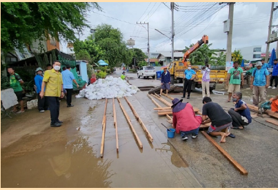
ดำเนินการบล็อกท่อระบายน้ำเพื่อป้องกันน้ำจากแม่น้ำไหลย้อนเข้าท่อระบายน้ำ บริเวณท้ายซอยแสงสวรรค์
