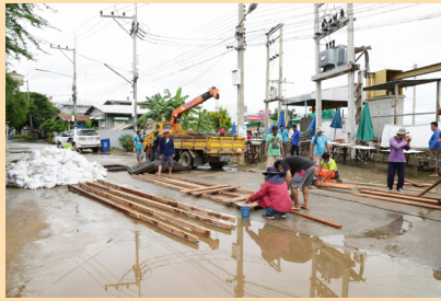
ดำเนินการบล็อกท่อระบายน้ำเพื่อป้องกันน้ำจากแม่น้ำไหลย้อนเข้าท่อระบายน้ำ บริเวณท้ายซอยแสงสวรรค์
