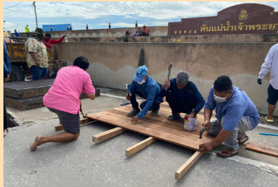
เจ้าหน้าที่ให้การบล็อกท่อระบายน้ำบริเวณหน้าเงินทุนหลักทรัพย์ เนื่องจากระดับน้ำแม่น้ำเพิ่มสูงขึ้น เพื่อป้องกันน้ำแม่น้ำไหลย้อนเข้ามา และใช้เครื่องสูบน้ำไฟฟ้าใต้ดินสูบน้ำออกไป
