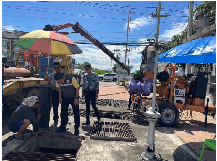
ติดตั้งเครื่องสูบน้ำดีเซลเพิ่มข้างศาลอุทธรณ์ภาค 6 เสริมเครื่องใต้ดินเดิม 4 เครื่อง หากไฟดับก็ยังสูบน้ำได้
