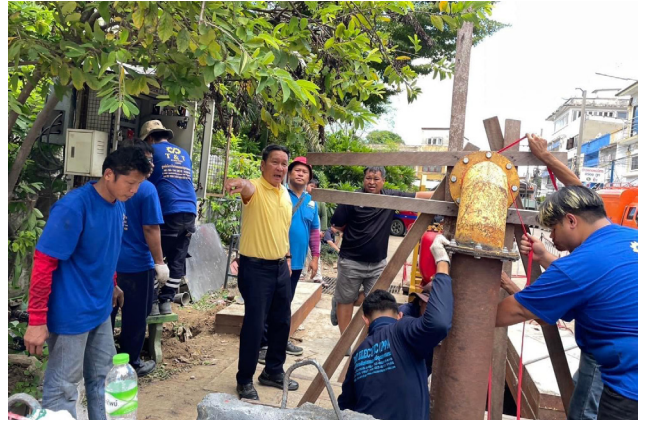
บล็อกท่อกันน้ำเข้ามาที่วัดตะแบก เตรียมพร้อมรับน้ำเหนือที่จะมา
