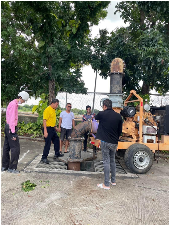
ติดตั้งเครื่องสูบน้ำดีเซลเพิ่มข้างศาลอุทธรณ์ภาค 6 เสริมเครื่องใต้ดินเดิม 4 เครื่อง หากไฟดับก็ยังสูบน้ำได้
