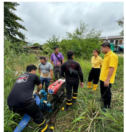
ติดตามการติดตั้งเครื่องสูบน้ำในพื้นที่ซึ่งส่วนใหญ่เป็นพื้นที่แอ่ง พื้นที่ลุ่มต่ำ ที่ยังมีปัญหาน้ำท่วมขัง
