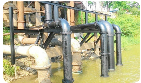
ปรับปรุงต่อท่อทางดูด โรงสูบน้ำ 2
