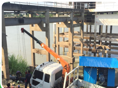
ติดตั้งหม้อแปลงไฟฟ้า1000 kVA โรงสูบน้ำ 2
