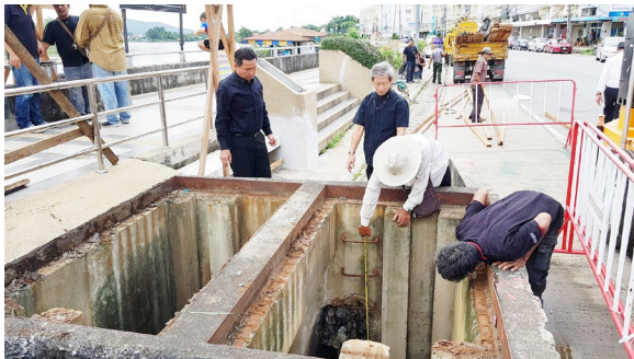
ตรวจสอบระบบระบายน้ำภายในเขตเทศบาลนครนครสวรรค์ พร้อมสั่งการบล็อกท่อระบายน้ำเพิ่มเติม เพื่อป้องกันน้ำจากแม่น้ำ เจ้าพระยาดันยอนเข้าท่อระบายน้ำ
