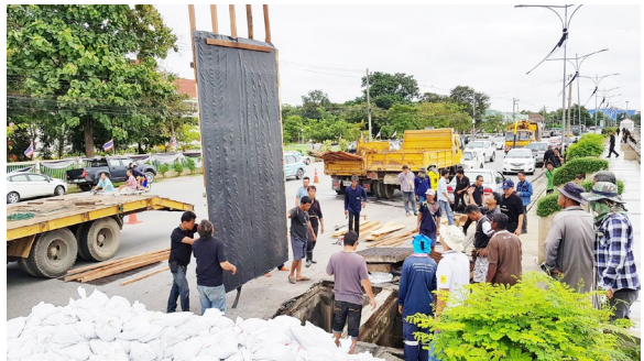
ตรวจสอบระบบระบายน้ำบริเวณชุมชนหนองสาหร่ายและพื้นที่ลุ่ม ต่ำใกล้เคียง พร้อมสั่งการบล็อกท่อระบายน้ำเพิ่มเติมจุดที่ 6 บริเวณ ถนนริมแม่น้ำแยกศาลเยาวชนและครอบครัว
