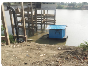
ก่อสร้างแพสูบน้ำ 3 โรงสูบน้ำ 3
